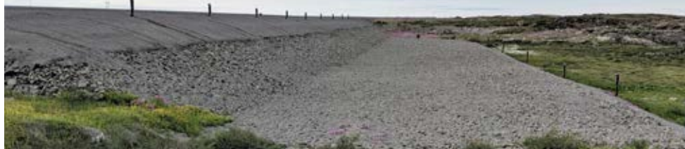
Travaux d'adaptation à grande échelle (contrepois en remblai à convection d'air) sur la piste d'atterrissage à Puvirnituq, Nunavik, 2010 ( Air convection embankment, Puvirnituq airstrip, Nunavik, 2010 ).
